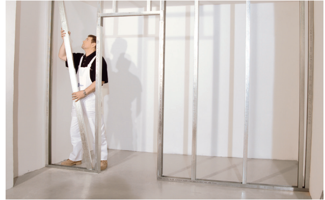
Válaszfal tartószerkezetének szerelése –függőleges CW-profilok
