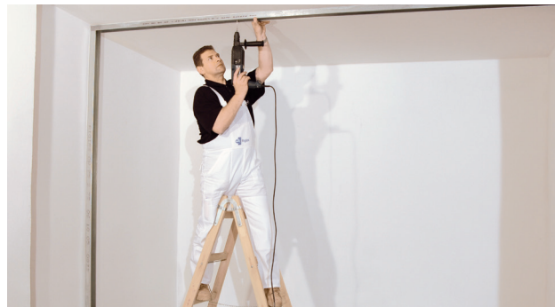
A válaszfal tartószerkezetének szerelése – határoló profilok (vízszintes UW, függőleges CW)
