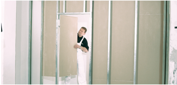
Falborítás szerelése – a válaszfal egyik oldala
