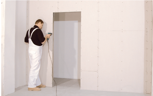
Falborítás szerelése – a válaszfal másik oldala
