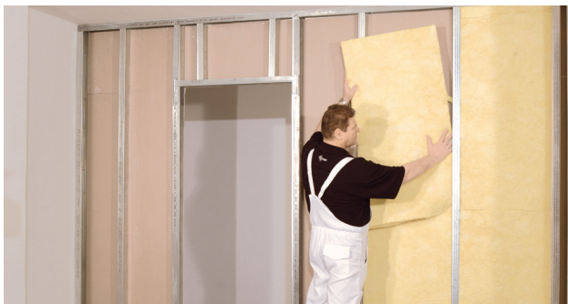
Ásványgyapot szigetelés elhelyezése a válaszfal üreges részében
