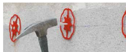
A Baumit ragasztótárcsát a furatba kell illeszteni és a műanyag tűske beütésével rögzíteni.
