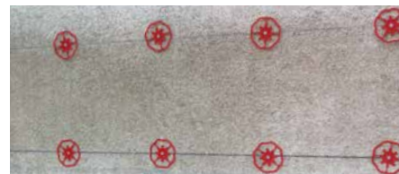
A Baumit ragasztótárcsákat 40 x 40 cm-es rasterben kell felhelyezni.
