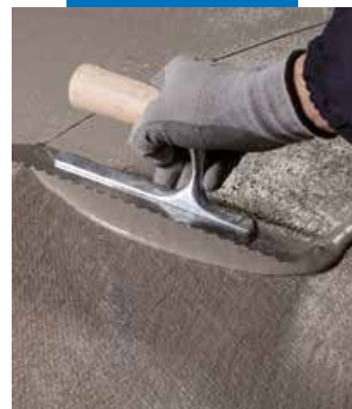
A második réteg Mapelastic Turbo felhordása az első, Mapetex Sel-lel erősített rétegre
